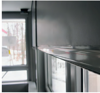
Verdunkelung mittels Blockout-Gewebe
