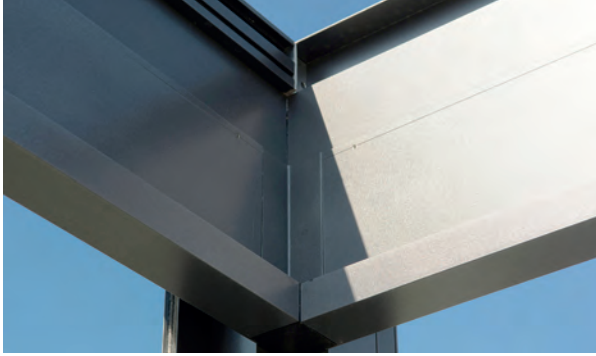
Wasserablauf in der Stütze
